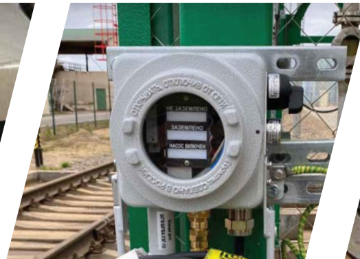
索德鲁热斯特沃矿场 防爆按钮控制面板和接地系统的设计和 供应
